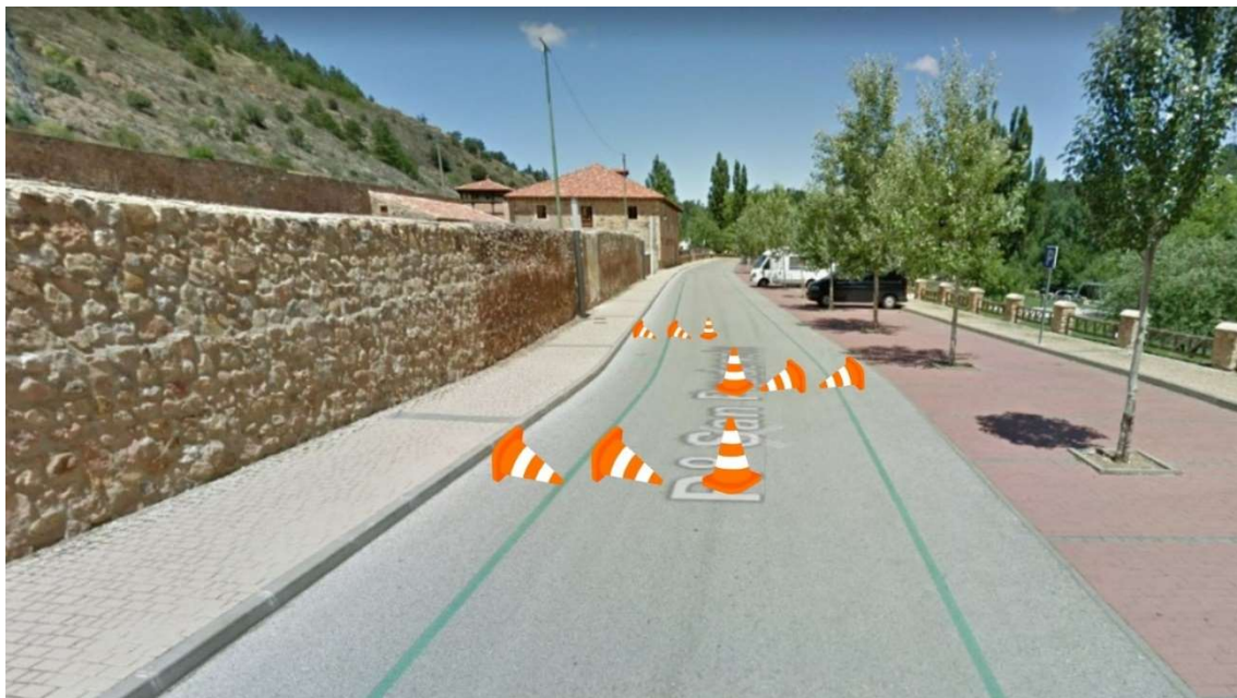
Zona 2 después del túnel
